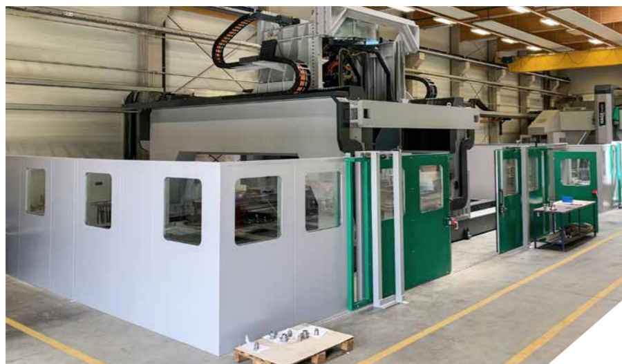
Die FSW Anlagen im HAGE FSW Kompetenzzentrum
