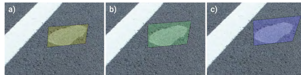
Prognoseergebnisse: (a) Original Schaden, (b) Prognose nach 1 Jahr, (c) Prognose nach 2 Jahren
